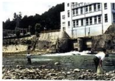
イワナがいる昭和電工広津発電所付近
